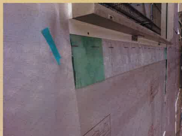
緑色のテープが貼られています。緑色のテープは良好な施工であることを示します。
