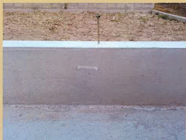
白色のテープが貼られています。白色のテープは素晴らしい施工であることを示します。
